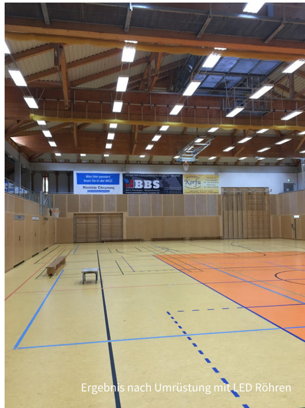
Ergebnis nach Umrüstung mit LED Röhren
