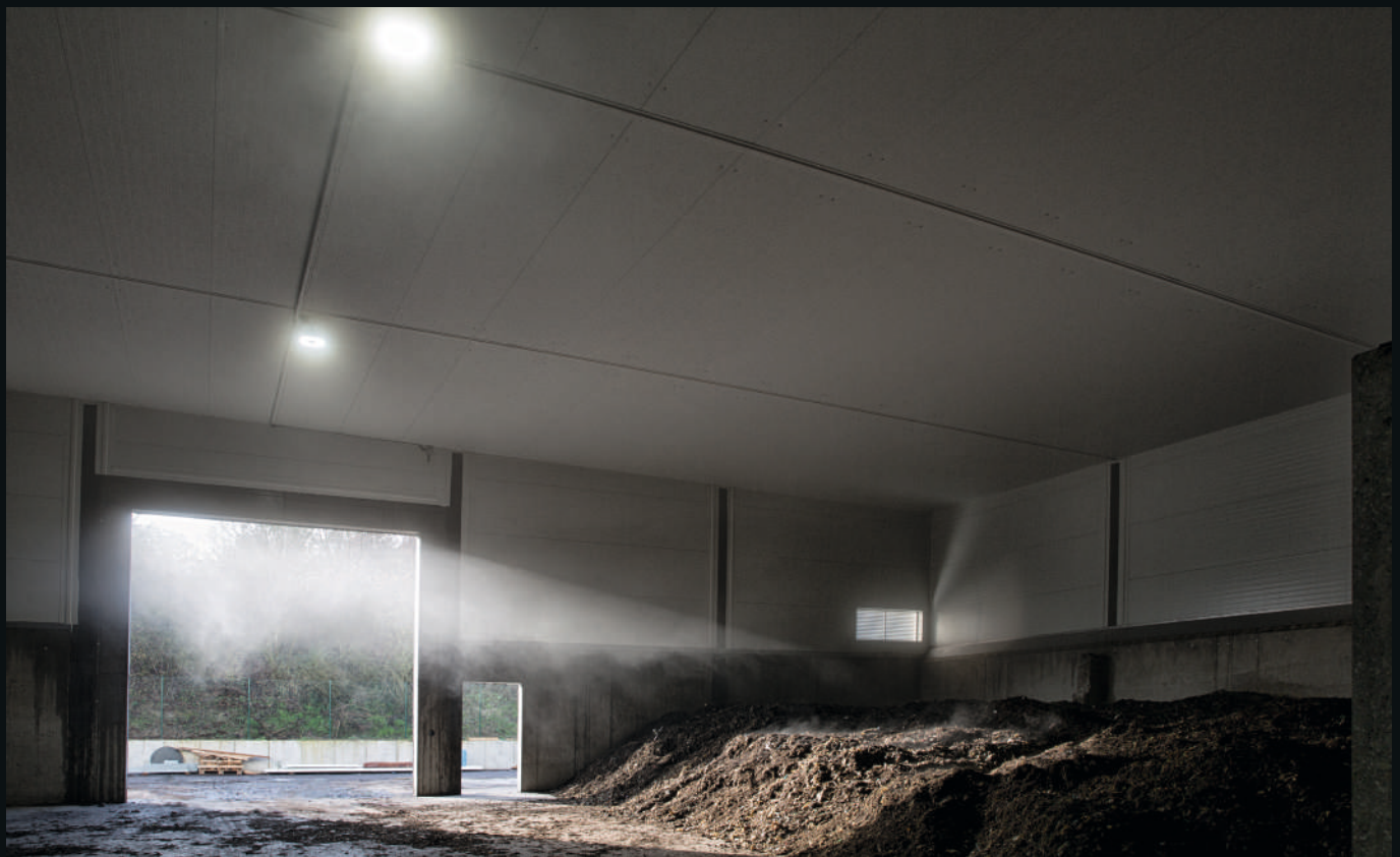
BVB Westheim Kompostieranlage
